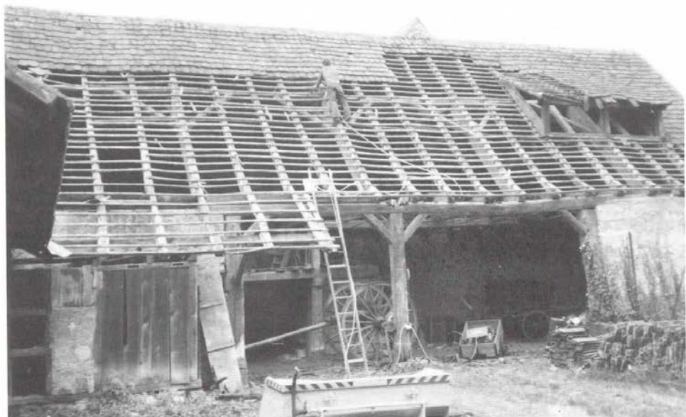
Sanierung des Daches vom Wagenschopf, August 1989 (Foto K. Ehrler-Nickola)
