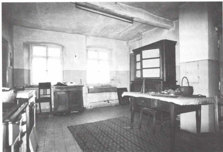
Küche (Raum 1.4) im Erdgeschoß vor der Restaurierung
