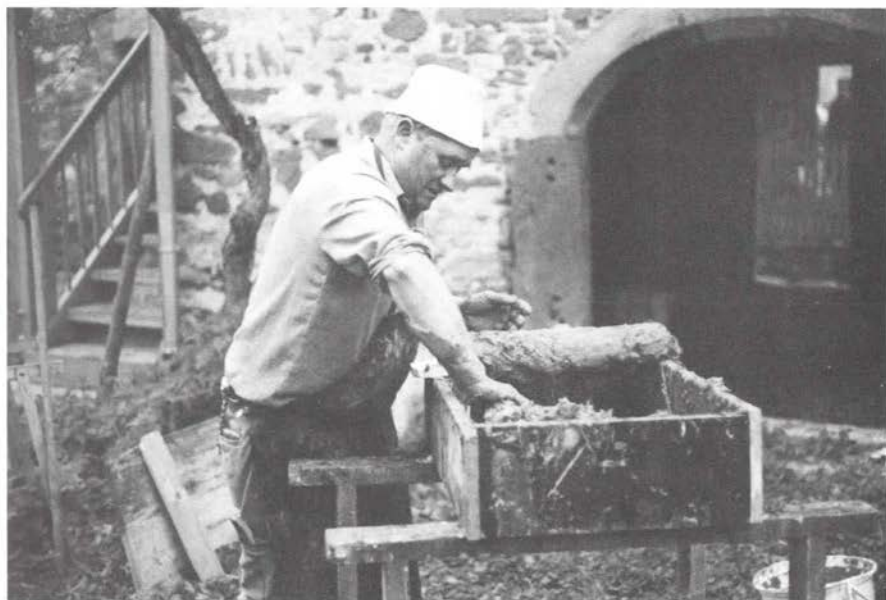
Herstellung von Lehmwickeln für Reparaturarbeiten am Backhaus, Mai 1991
